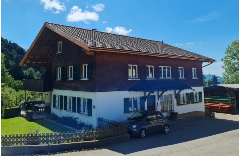
Abbildung: 8 Foto von der Inaugenscheinnahme des Gebäudes. (EFH Sanierung)
