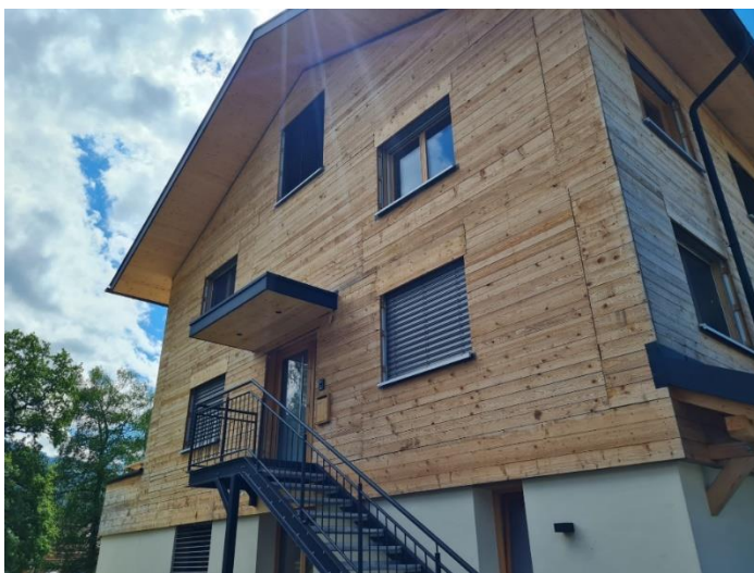
Abbildung 9: Foto von der Inaugenscheinnahme des Gebäudes. (MWH Neubau)
