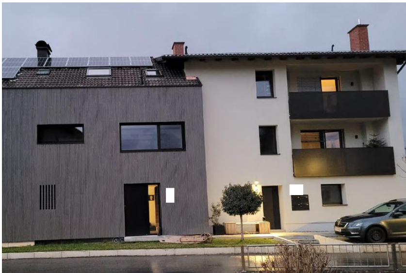
Abbildung 10: Foto von der Inaugenscheinnahme des sanierten Gebäudes (rechts). Hausnummern wurden unkenntlich gemacht. (MWH Sanierung)
