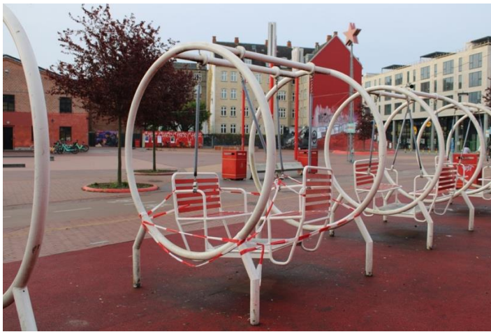
Abbildung 20: Heruntergekommene Bank ( Bench, Porto, Portugal ) (o.); Defekte Schaukel & Abnutzung des Bodenbelages ( Swing Bench, Baghdad, Iraq ) (u.) Quelle: eigene Aufnahmen
