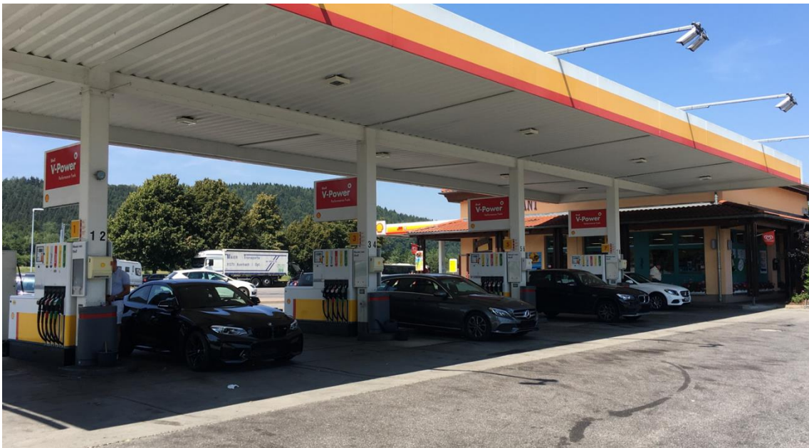
Abbildung 30: Zapfsäulen am Autohof in Aichstetten
