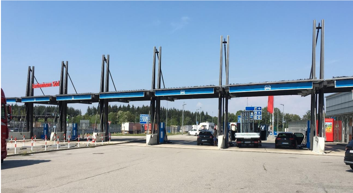
Abbildung 29: Sechs Zapfsäulen an der Tankstelle Lechwiesen Süd
